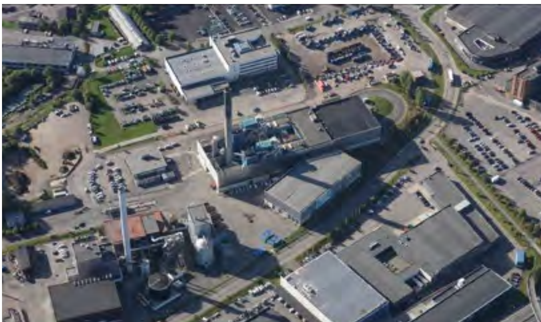
Energigjenvinningsetatens anlegg på Haraldrud behandler hovedsakelig husholdningsavfall, og noe næringsavfall - totalt ca. 100 000 tonn i året. Anlegget produserer energi i form av varmt vann som distribueres til fjernvarmenett i Groruddalen og til Oslo sentrum.
