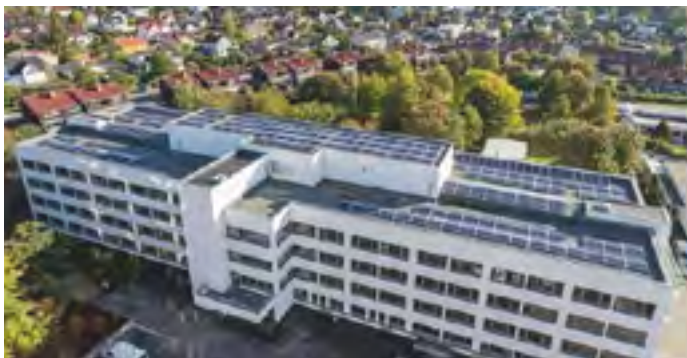
Økern sykehjem: Oslos største solcelletak. Rehabiliteringsprosjekt som har ført til at energibehovet er redusert med 68 prosent sammenlignet med dagens energibehov og 33,5 prosent i forhold til et referansebygg etter TEK 10. FutureBuilt forbildeprosjekt. Byggherre: Omsorgsbygg..
