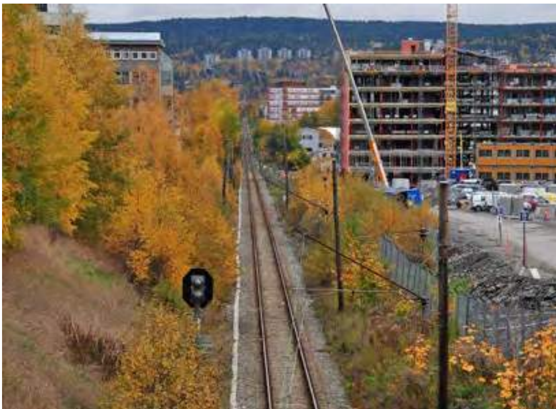
Alnabanen, godslinje med en trasé som kan utvides med gang- og sykkelvei i samarbeid med Jerbaneverket.
