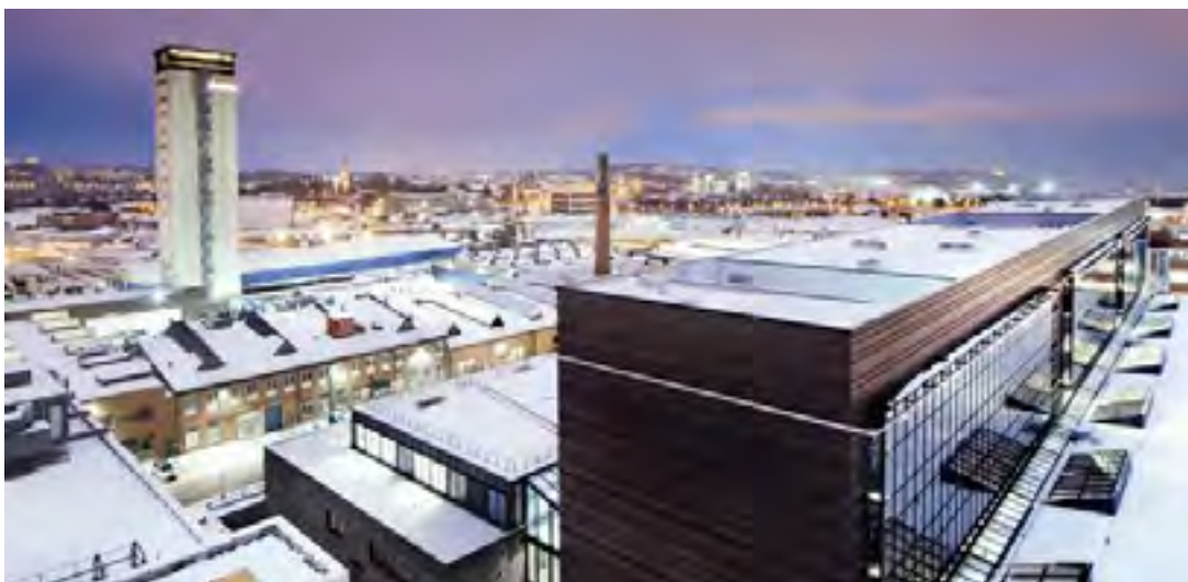
Kuben Videregående skole trekker vekselvirkning mellom undervisning og næring og bidrar til utvikling av det omkringliggende næringsområdet i Kabelgaten på Haraldrud.
