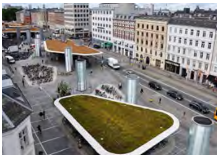
Nørreport stasjon, København. Attraktiv utforming med overdekket og åpen sykkelparkerig. Romslige soner til opphold og bevegelse. COBE arkitekter, 2015.
