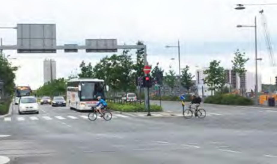
Håkon 5.s gate, Oslo. Stamvei med bymessig utforming.
